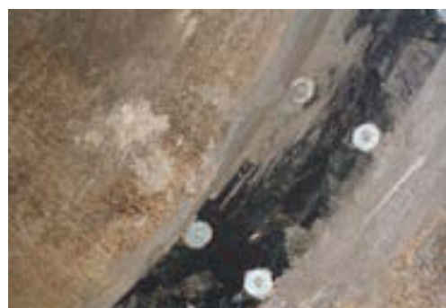
8. Anchrägung der Abdeckung, um Ablagerungen zu vermeiden
