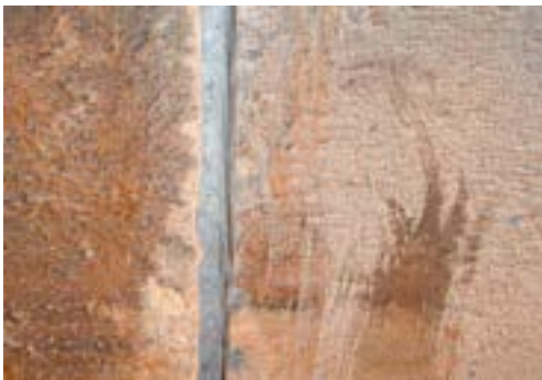
3. Mineralische Abdichtung Fugenuntergrund
