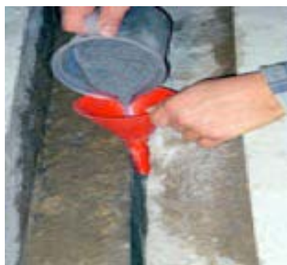
2. Einfüllen des Abdichtgranulats
