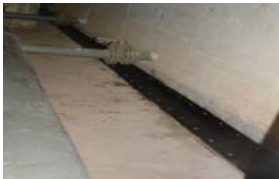
2. Nachher: Mit dem Einsatz von Quellpolymeren und Abdeckmanschette erzielt man einen dauerhaft trockenen Keller
