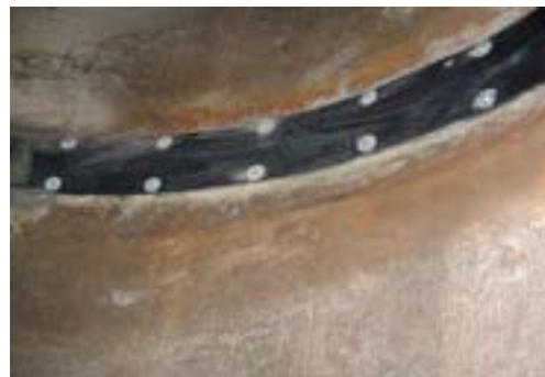
6. Montage Manschettenabdeckung mit Edelstahlschrauben
