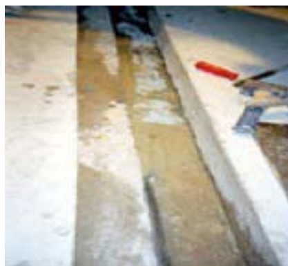
4. Verfüllung des oberen Fugenraums mit wasserdichtem Reparatur-Mörtel
