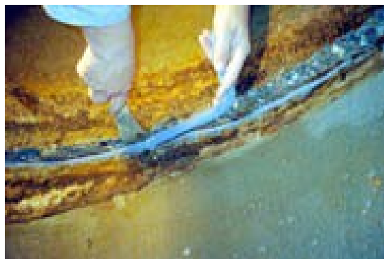
Fugenabdichtung durch Abdichtschläuche
