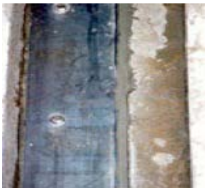
5. Verfüllung der verbleibende Bewegungsspalten, elastisch
