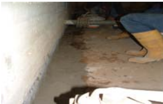
5. Mineralische Fugenoberraum-Verfüllung über dem Quellgranulat und zur satten Auflage der Manschette
