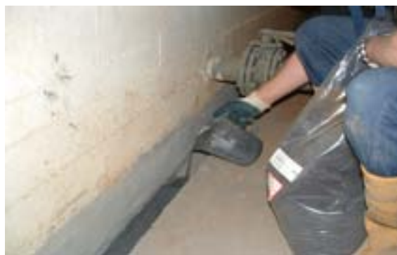
4. Einbringen des Quellpolymer-Granulates, ca. 4 Ltr./m Diese Menge reicht für ein Dichtvolumen von ca. 1 m 3 /m
