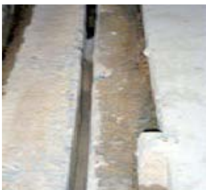
1. Mineralisches Abdichten der Fugensohle
