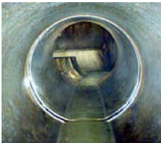
Vollständig sanierte Rohrmuffe
