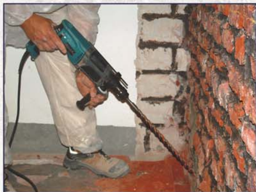
Bohrung für eine Horizontalsperre
