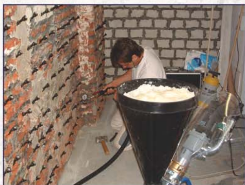
Verpressung mit Gelpumpe
