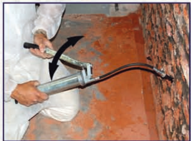
Dichtgel in die Wand pressen
